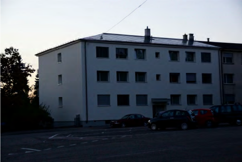
Riehen, Hörnliallee 69 Fassadensanierung, Photovoltaik, Terrassenverbreiterung
