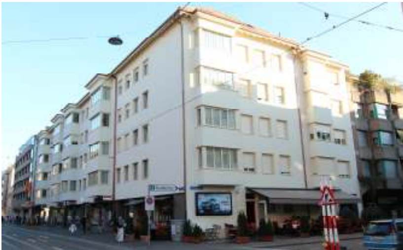
Basel, Güter-/Pfeffingerstrasse: DG-Ausbau, Fenster-/Rollladenersatz
