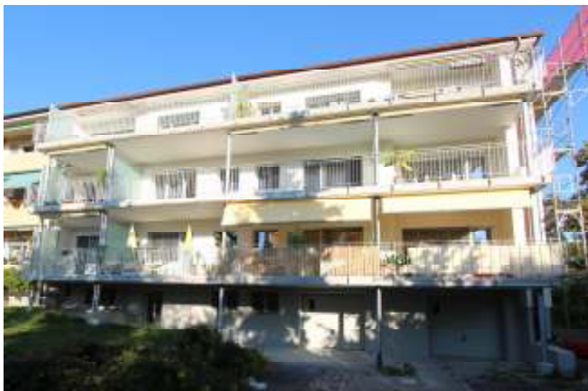
Riehen, Hörnliallee: Fensterersatz, Aussenisolation und Terrassenvergrösserung
