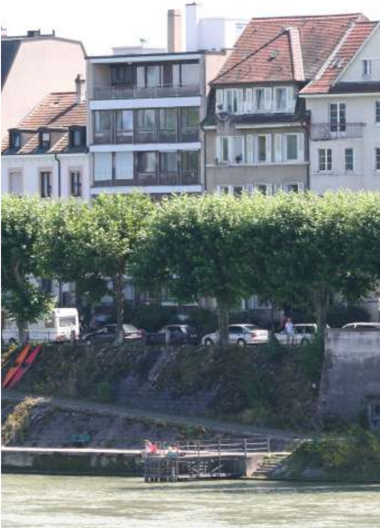
Sanierung und Zusammenlegung der beiden Gebäude
